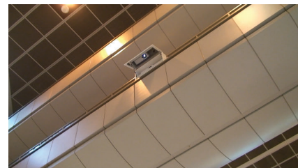
図 4 PC およびカメラの設置
