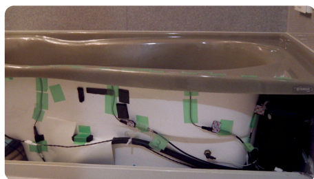
図 3 浴槽横のエプロン壁を取りはずした様子 Fig. 3 Side of bathtub without apron.
