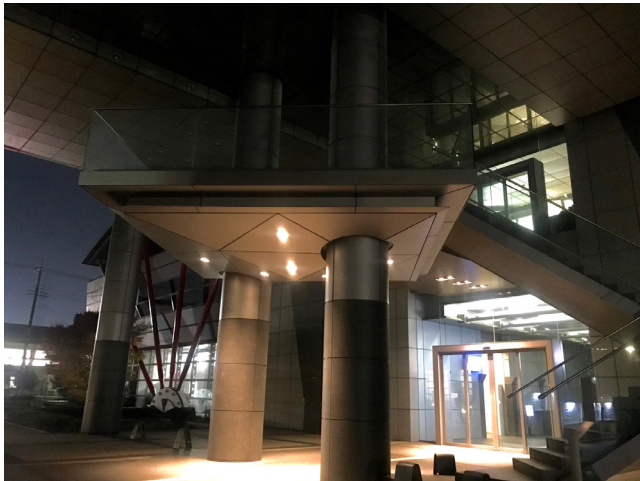
図 3 特殊な形状でエントランスが明確に判別できない建物
